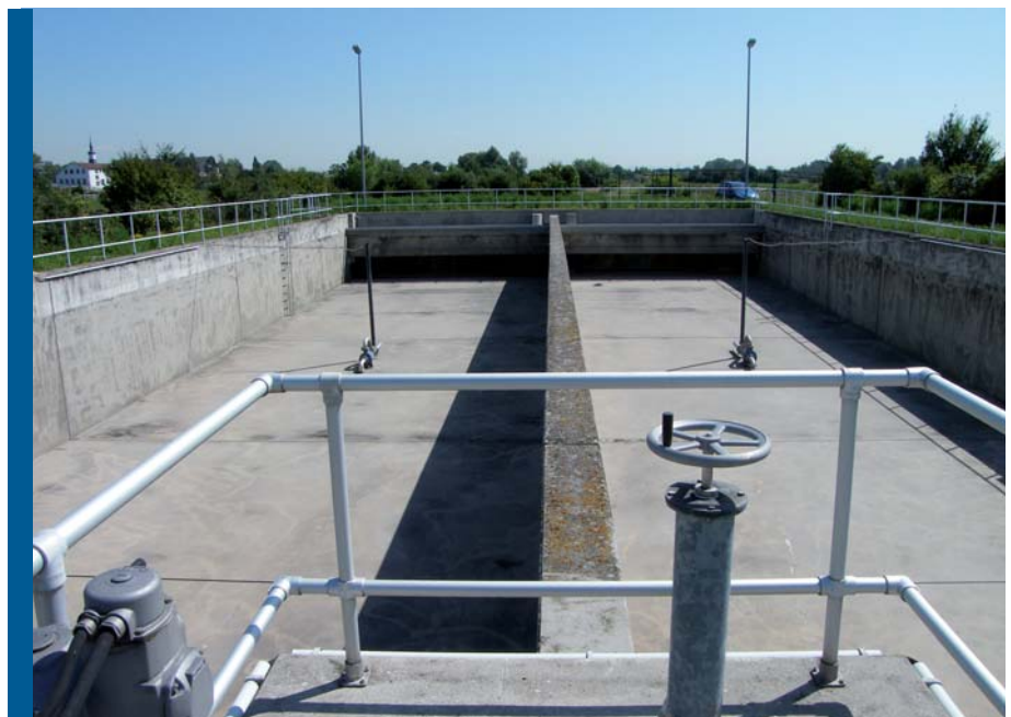
Eines von vier Regenüberlaufbecken der Gemeindewerke Haßloch
