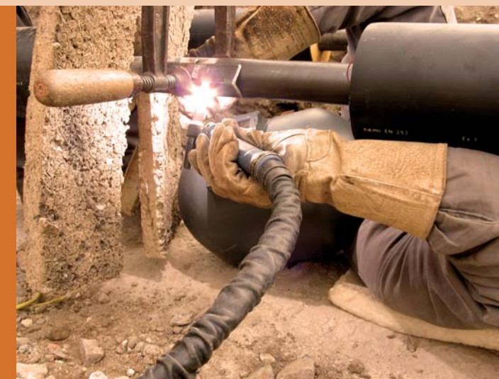
Ein Monteur beim Schweißen der Nahwärmeleitung im Neubaubgebiet „Südlich der Rosenstraße“
